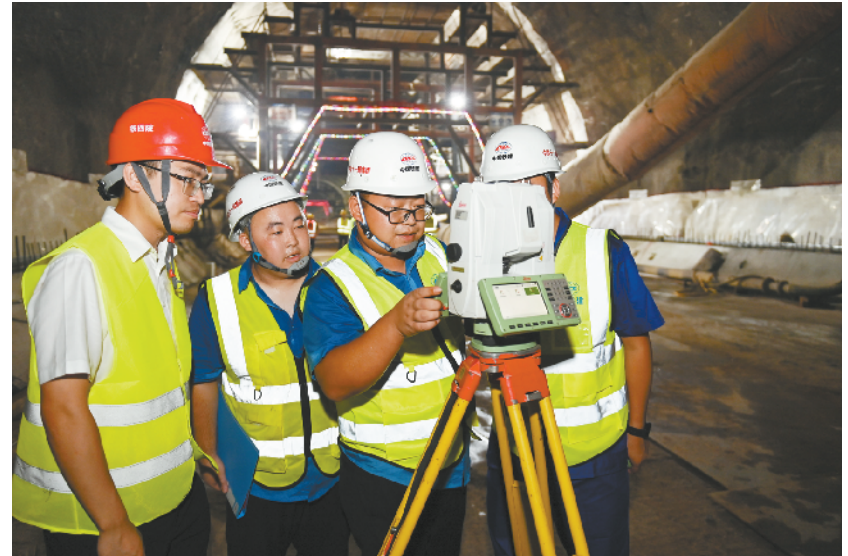
浙江:杭衢铁路全线最长隧道贯通
