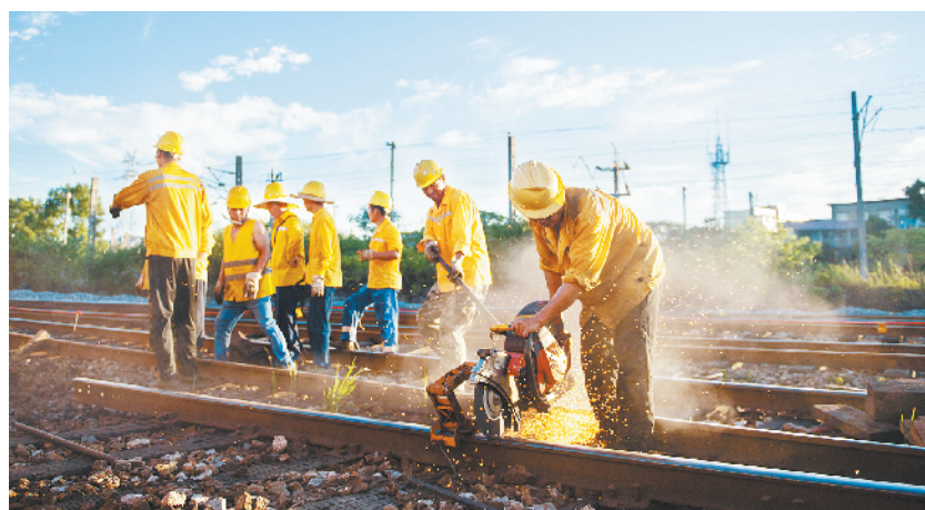
株洲北站换岔施工忙
