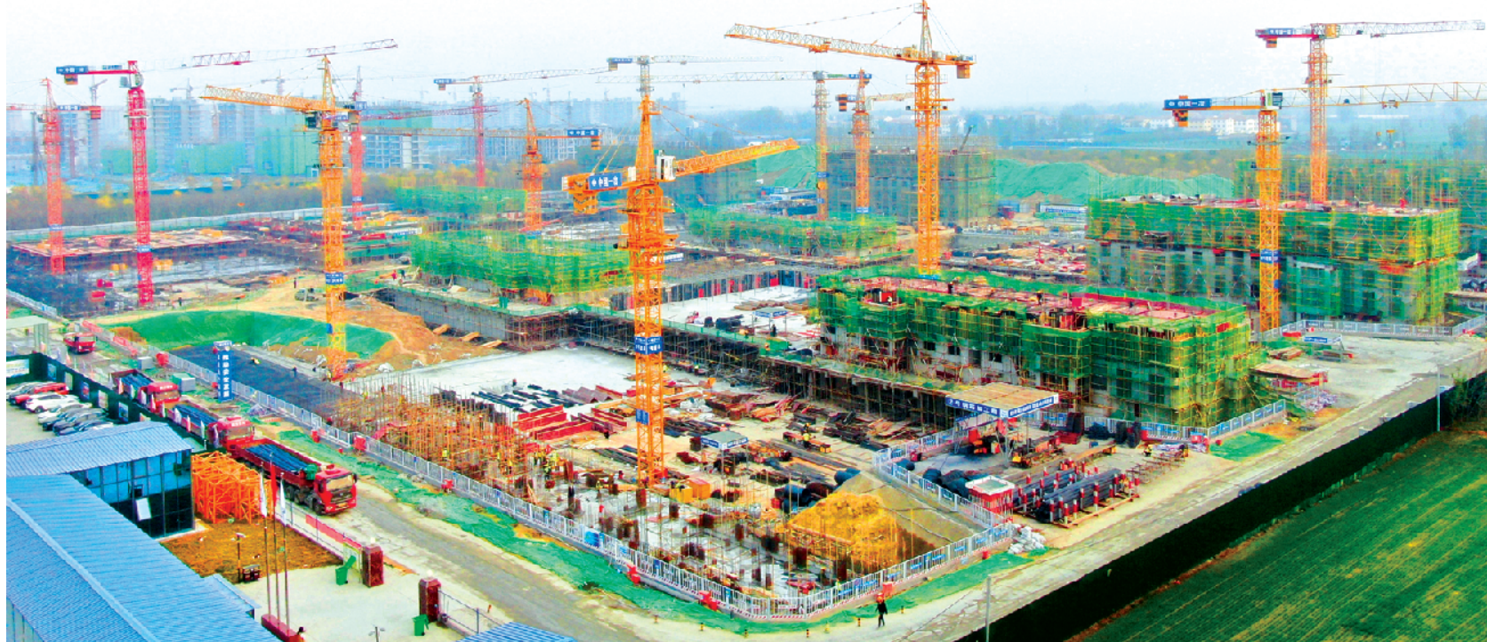
连日来,为确保民生福利早日落实,扶沟县各大民生项目正加足马力、火力全开,以最大的力度、最实的举措,抢抓建设工期,加快建设进度,兑现民生承诺。图为由中国一冶承建的扶沟县丁庄棚户区改造项目建设工地。记者 金月全 通讯员 刘心怡 摄
