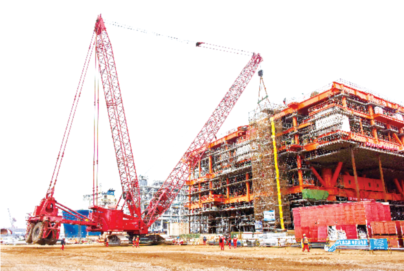
渤海湾千万方大气田最大组块青岛封顶
