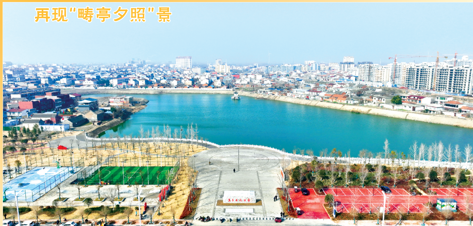
箕子是我国商代的一位富有正义感的政治家和文学家,曾被囚西华而筑台夜读。箕子读书台是古老西华的象征。近年来,西华县在城市建设中深挖历史文化底蕴,让传统文化“潮起来”“活起来”。新修建的箕子读书台位于西华县城西北箕子文化公园百亩湖面之中,台呈方形,青石铺就。台上方形箕子亭(祠),青砖砌筑,灰瓦覆脊,不失古代风貌,再现昔日“畴亭夕照”景观。 记者 张猛 摄
