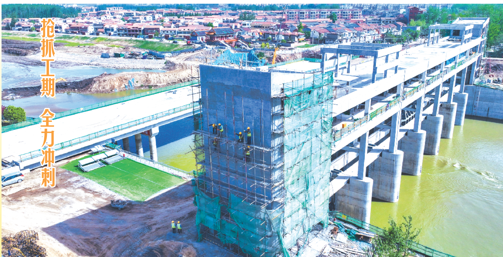
4月21日,工人在贾鲁河综合治理扶沟北关重建工程项目工地紧张施工(如图)。据悉,2021年11月25日,贾鲁河综合治理工程正式开工。作为我省灾后恢复重建的重点项目和标志性工程,贾鲁河综合治理工程总投资74亿元,长度148公里,周口段将近85公里,涉及扶沟县、西华县、川汇区三个县区,完工后将有力保障流域内的防洪安全。
