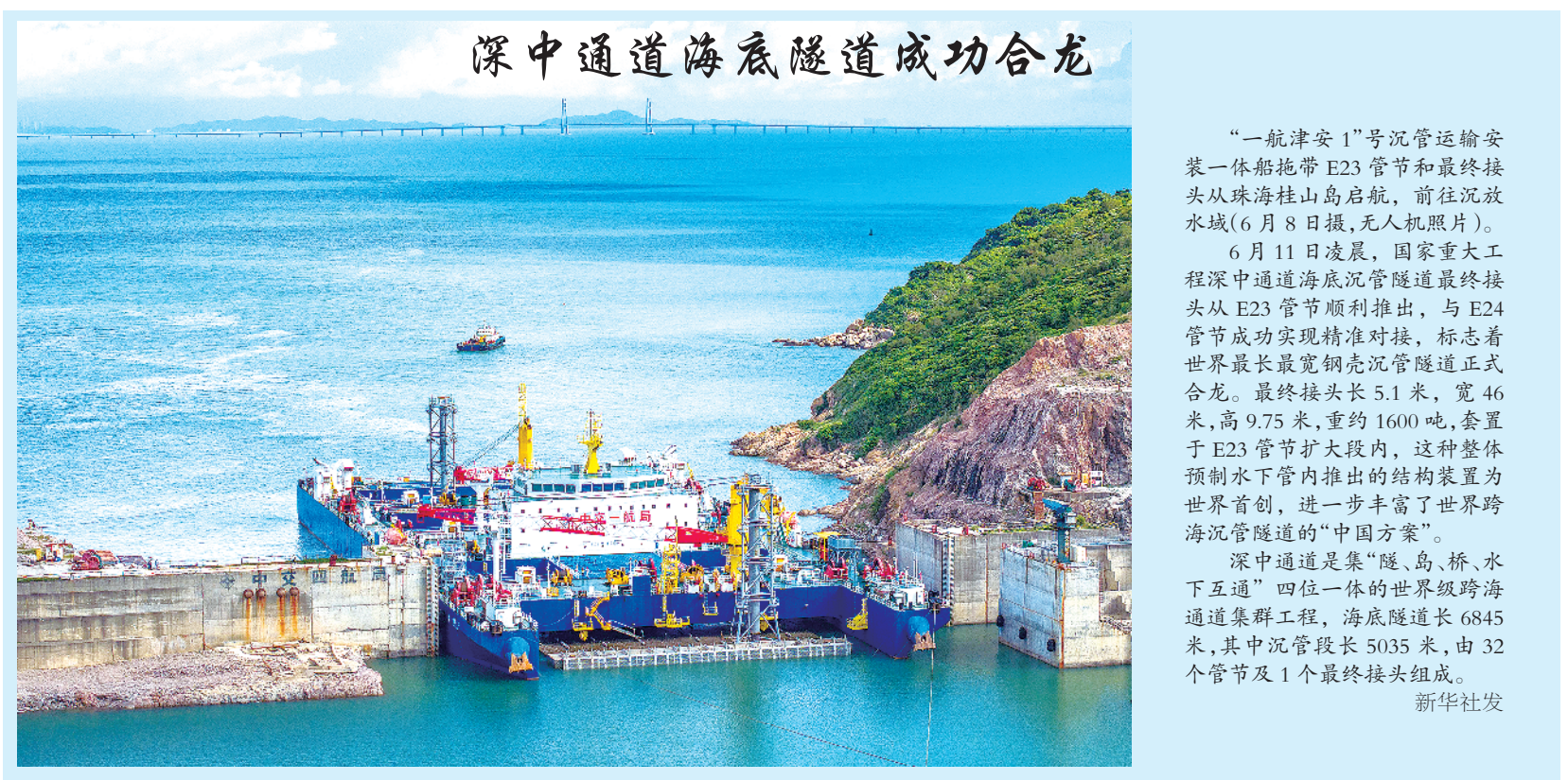
深中通道海底隧道成功合龙
