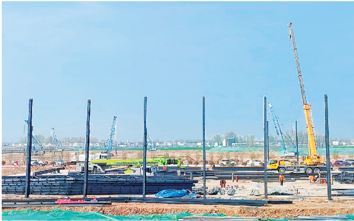
周口港中心港区中心作业区一期工程建设工地上桩机林立。
