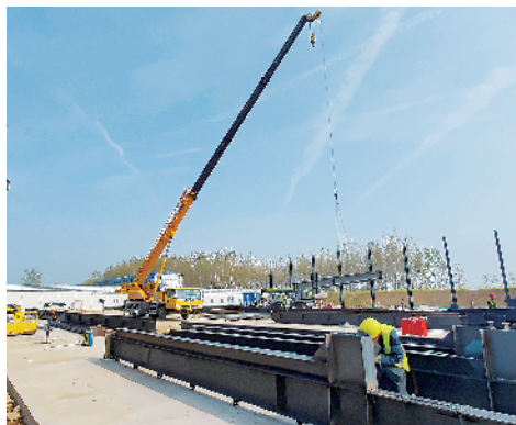
工人正在紧张施工。
