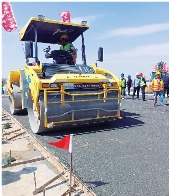
10月1日,沈卢高速沈遂二标项目路面水泥稳定碎石底基层试验段顺利完成摊铺,标志着项目建设进入路面施工新阶段。据了解,沈卢高速沈遂段项目是河南省高速公路“13445工程”第二批切块重点建设项目之一,全长105.962千米,其中沈遂段二标项目长27.167千米,均在项城市境内。
